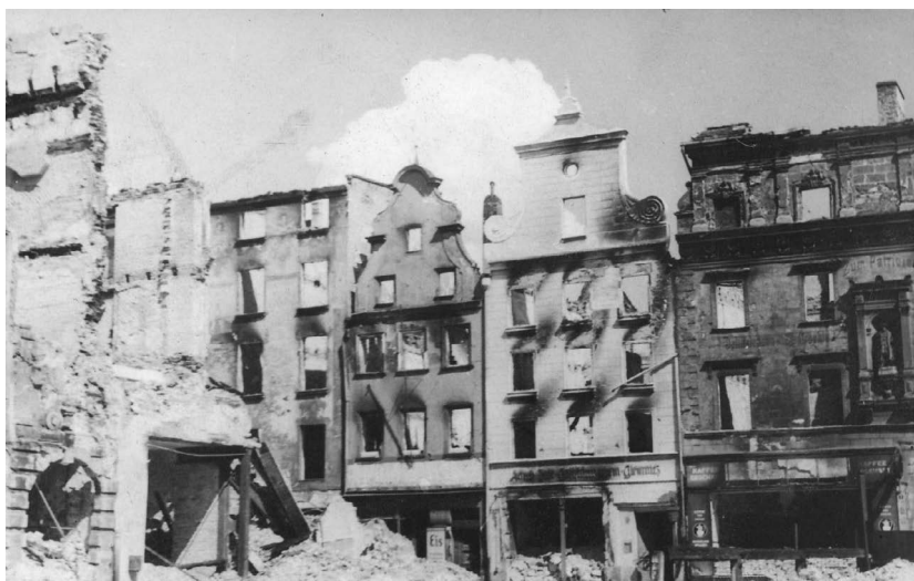
I.3. Zniszczenia w północnej części wschodniej pierzei Rynku, 1946 r.
