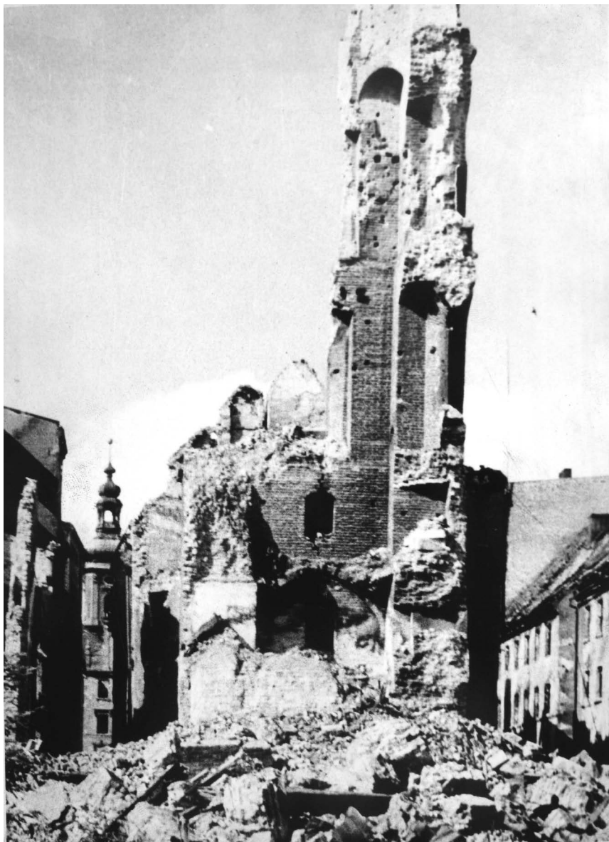
I.18. Widok od strony kościoła św. Jakuba na zniszczenia w zabudowie śródrynkowej, lata 40./50. XX w.
