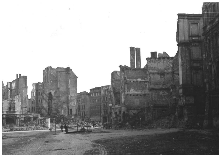
I.13. Ruiny domów nr 20–27 w Ryнку i przy ul. Celnej nr 6–12, przełom lat 40 i 50. XX w.
