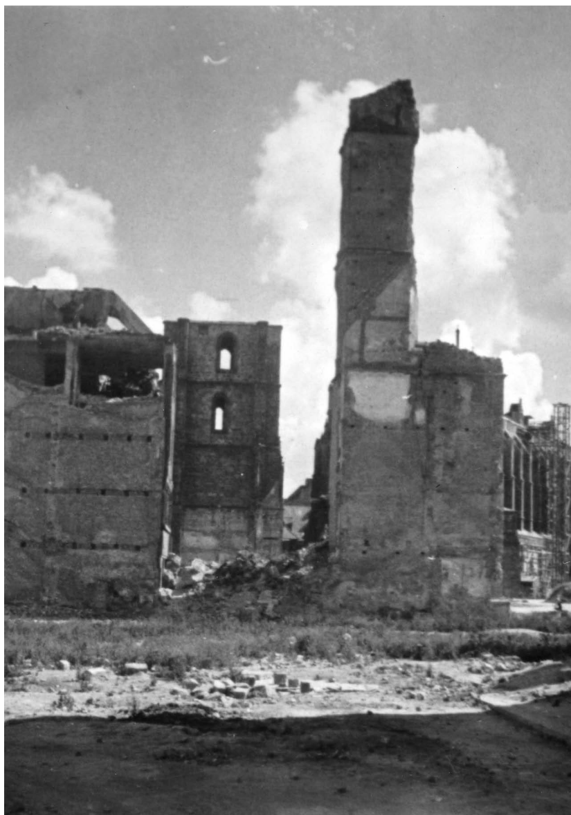
I.19. Widok od strony Rynku na ruiny wieży ratuszowej i wypaloną gotycką dzwonicę, przed 1957 r.
